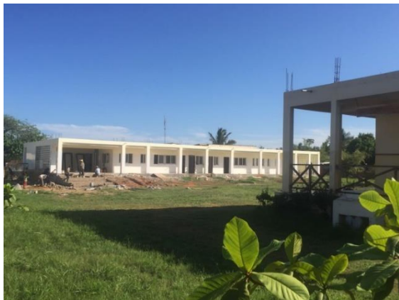
De laatste werkzaamheden december 2016
